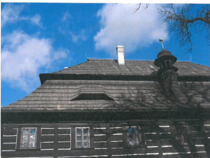
Šindelová střecha pobočky památníku K. H. Máchy v Doksech.
