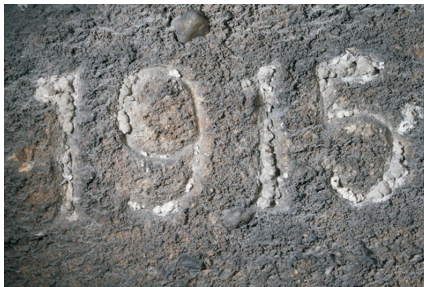
Obr. 2. Velmi dobře zachovaná rytina „1915“, lokalizace viz obr. 1. Přes velké množství vysrážených solí nejvíce pískovce stopy rozpadu (24.12.2011).
