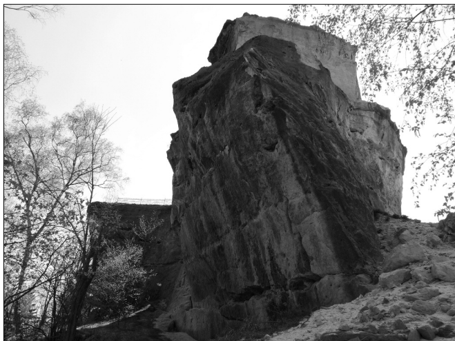
Obr. 2. Jestřebí u České Lípy. Hradní skála od severu se zříceným čelem a torzem původní převislé stěny
