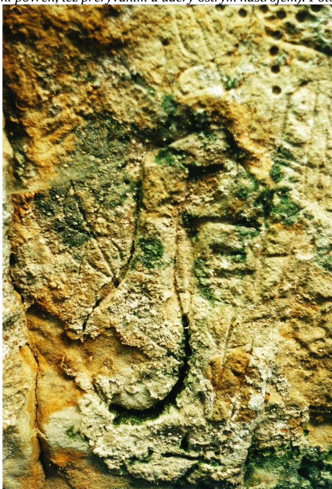
Obr. 21. Solnou korozí silně poškozené rytiny na stropu světnice s tzv. hladomornou Beneška v areálu hradu Valečov (pravděpodobně 16. století). Nejvýraznějším objektem je vyobrazení loutny nebo křivule se známou soudobou analogií pod Stříbrnými stěnami v NP České Švýcarsko. Foto P. Jenč, 2001
